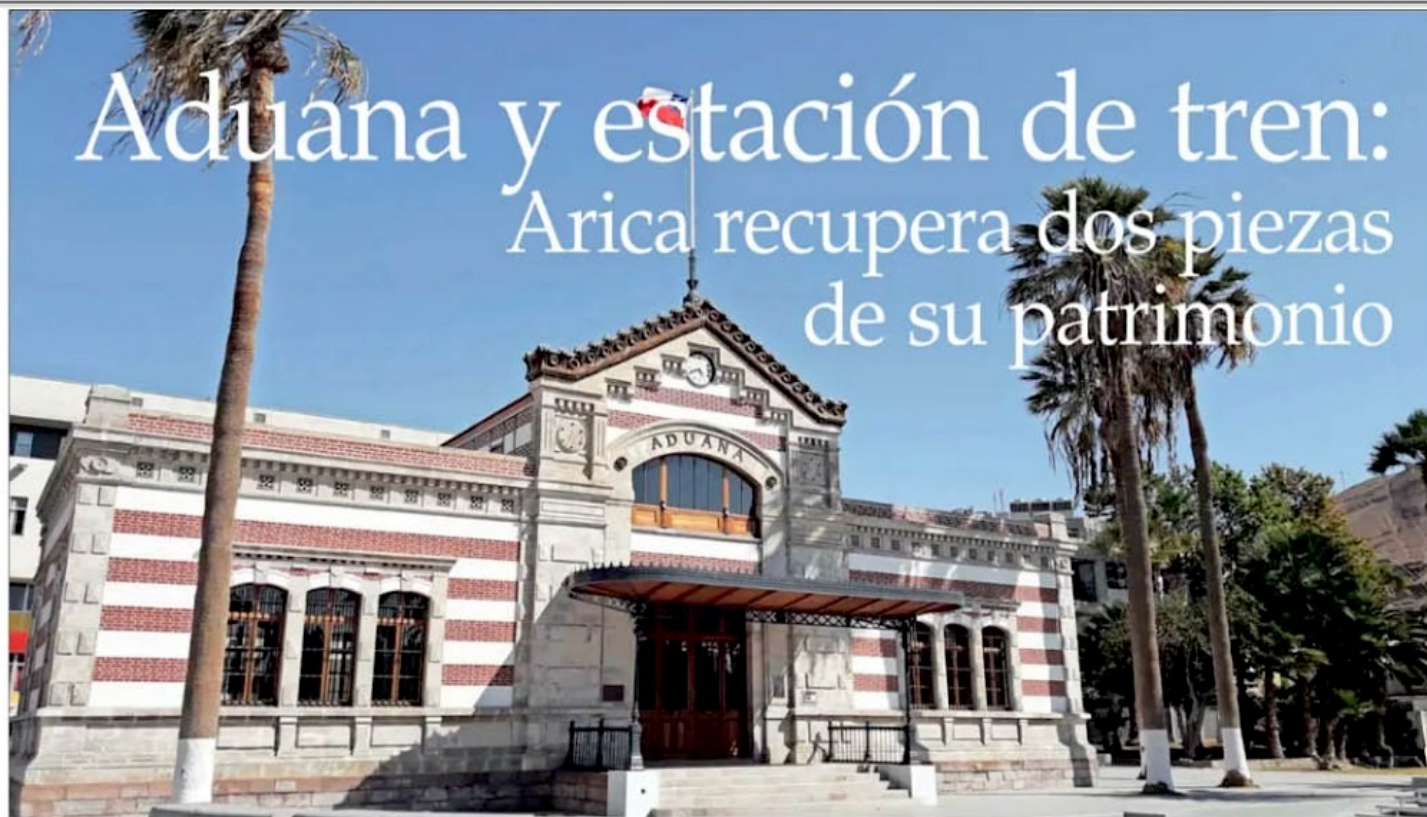
De 1874, la Aduana es un edificio neoclásico de elegancia. Su frontis a dos colores está definido por los ladrillos de cal blanca y arcilla roja.
